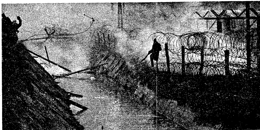
Mit Enterhaken wird der messerscharfe Nato-Draht weggerissen.
